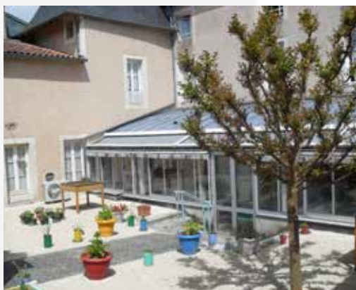
EHPAD - Salle des repas
